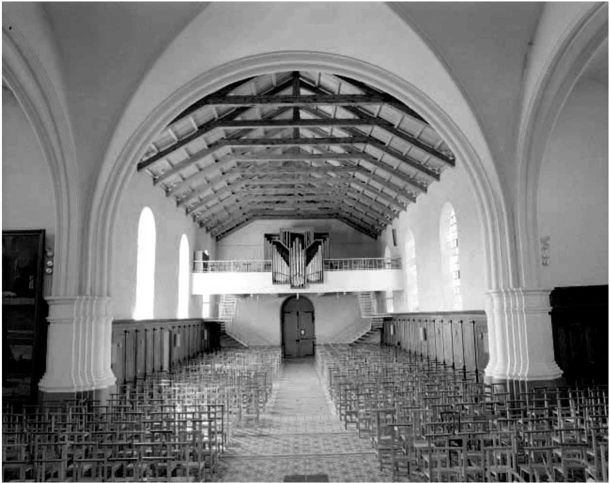
Intérieur : vue depuis le chœur.
