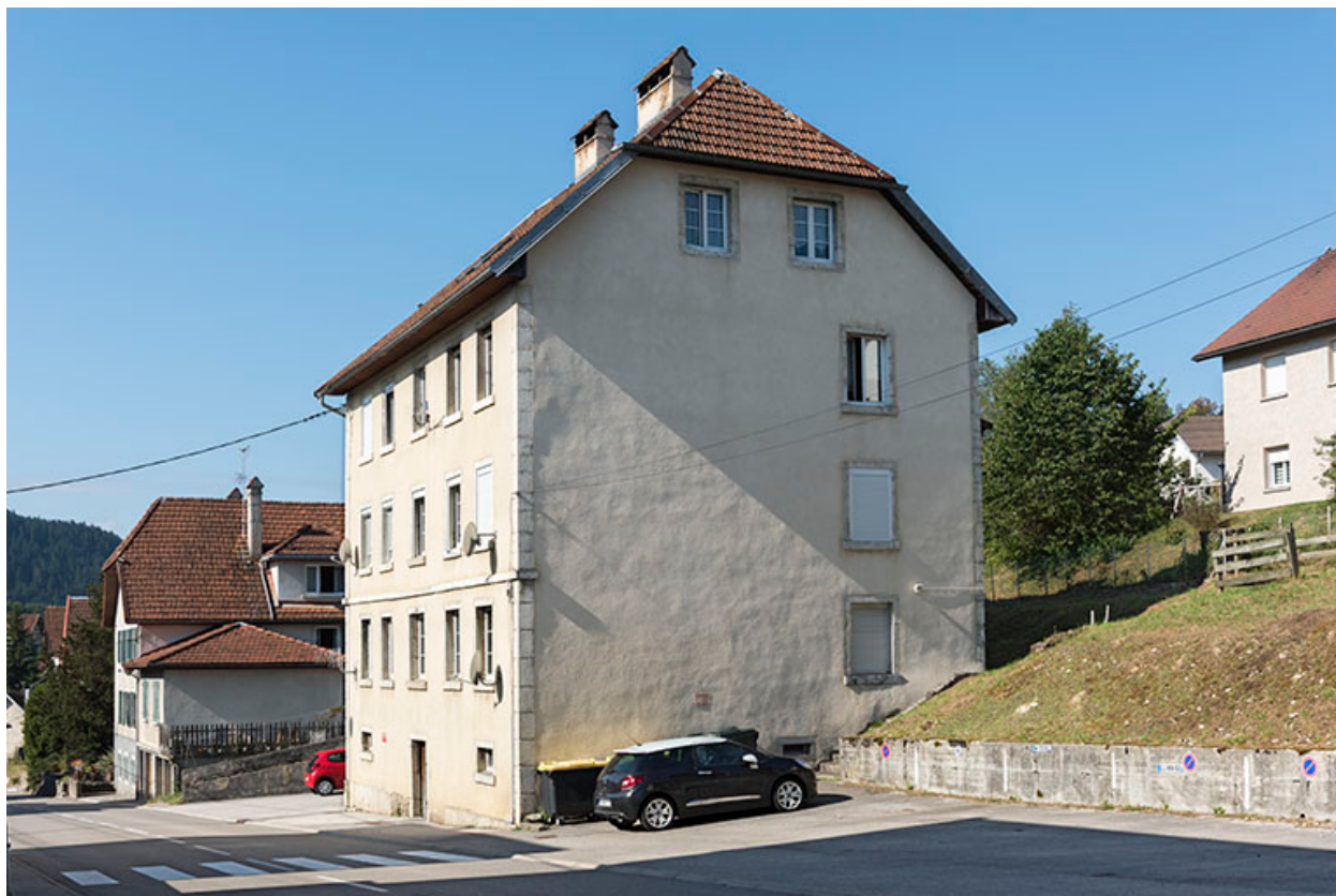
Façades antérieure et latérale droite.
