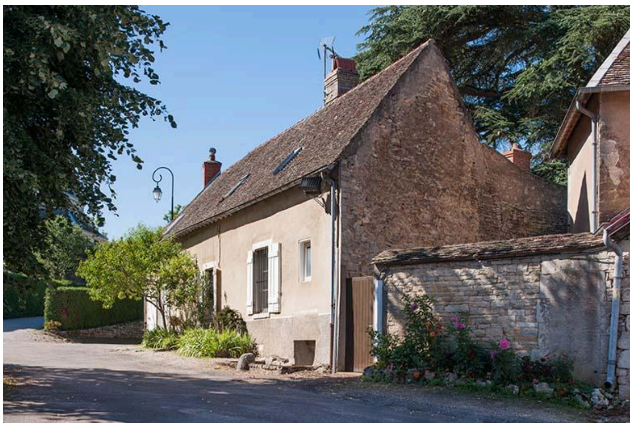
Bâtiment situé à l'ouest du presbytère
