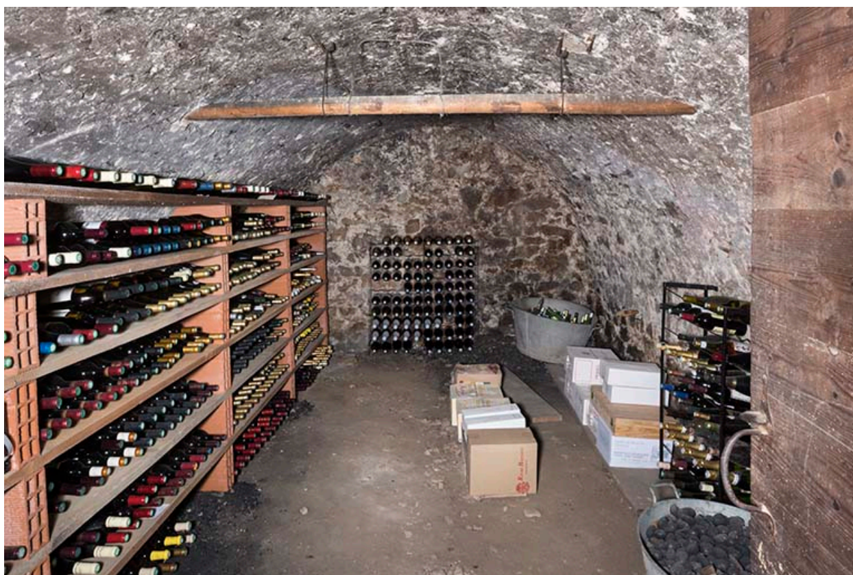
Deuxième étage de soubassement : cellier.
