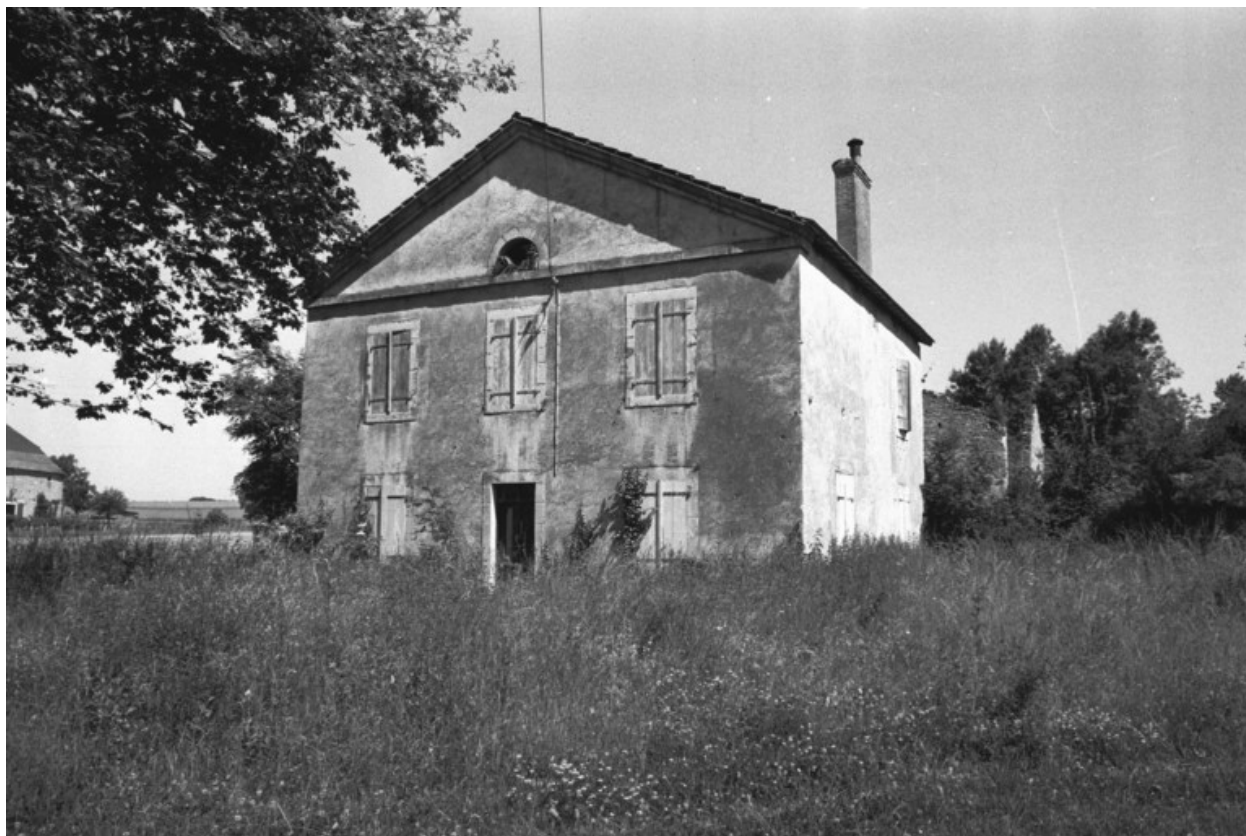
Logement patronal. Vue de trois quarts en 1981.
