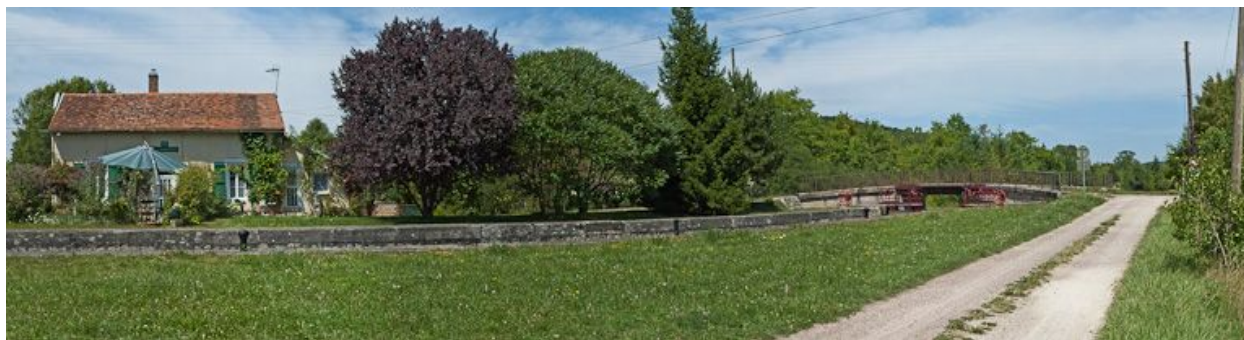
Vue d'ensemble du site d'écluse.
