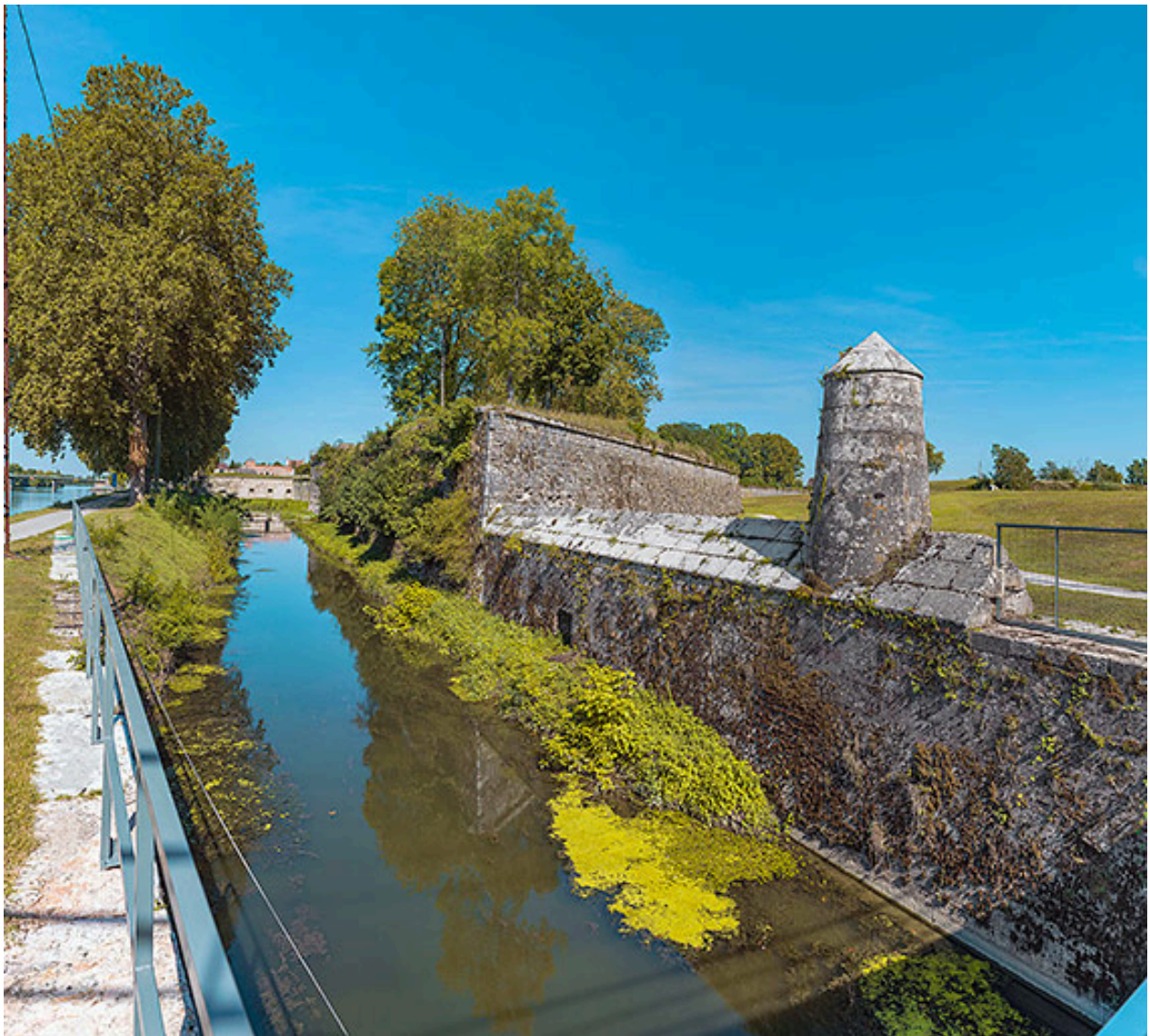
Le bastion et son batardeau.
