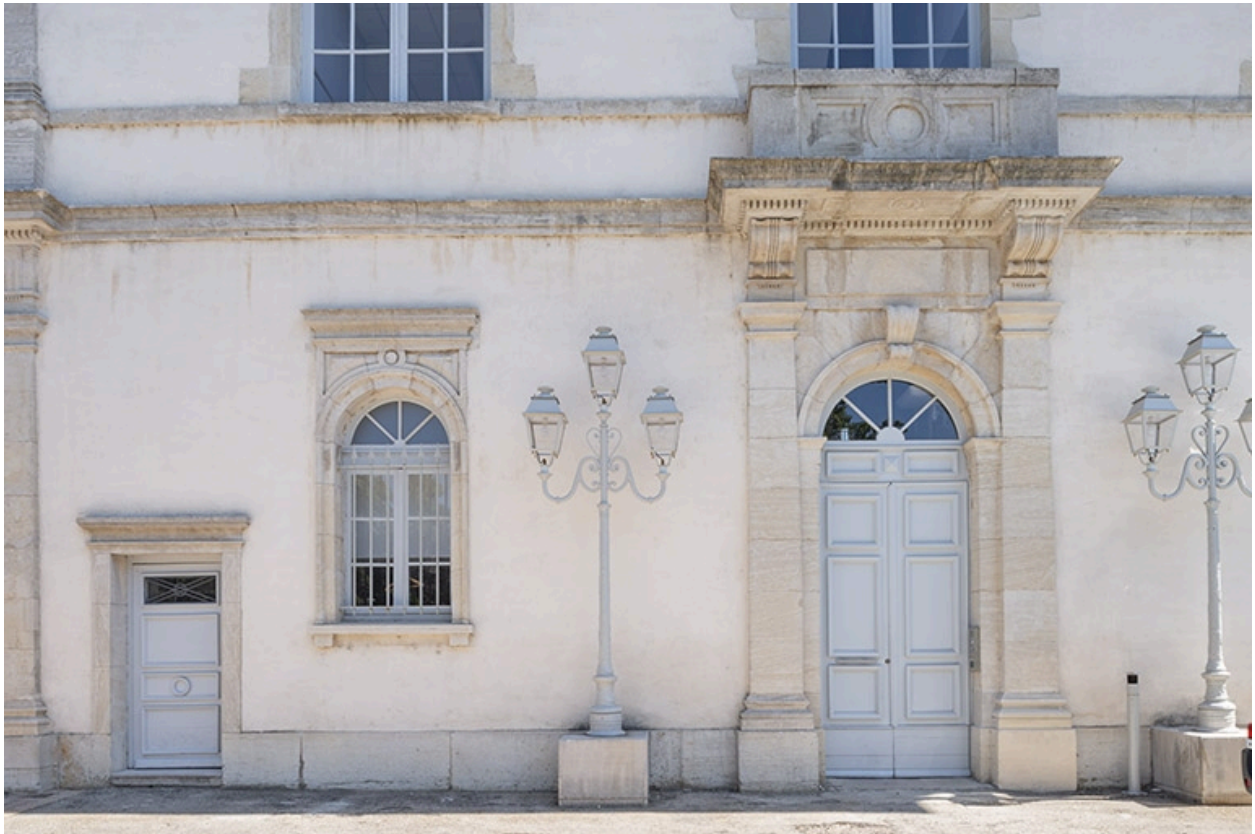
Façade postérieure : baies au rez-de-chaussée.
