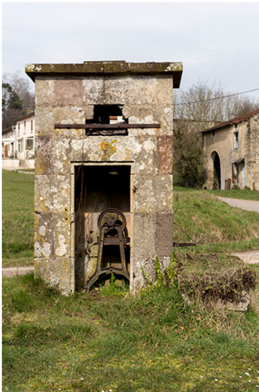
Vue de face (sud) de la fontaine.
