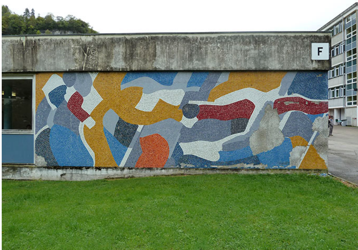
Vue générale, avant masquage par façade.
