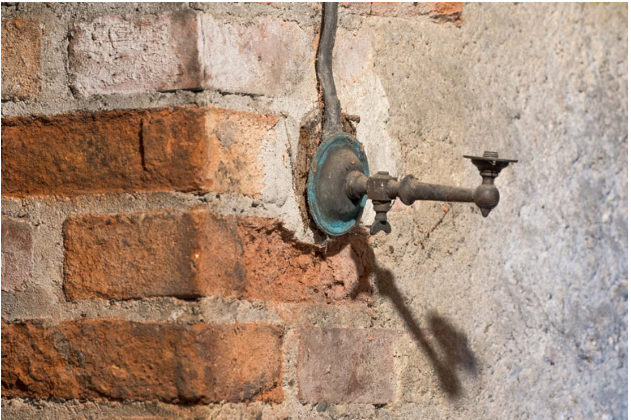
Luminaire d'applique au sous-sol.
