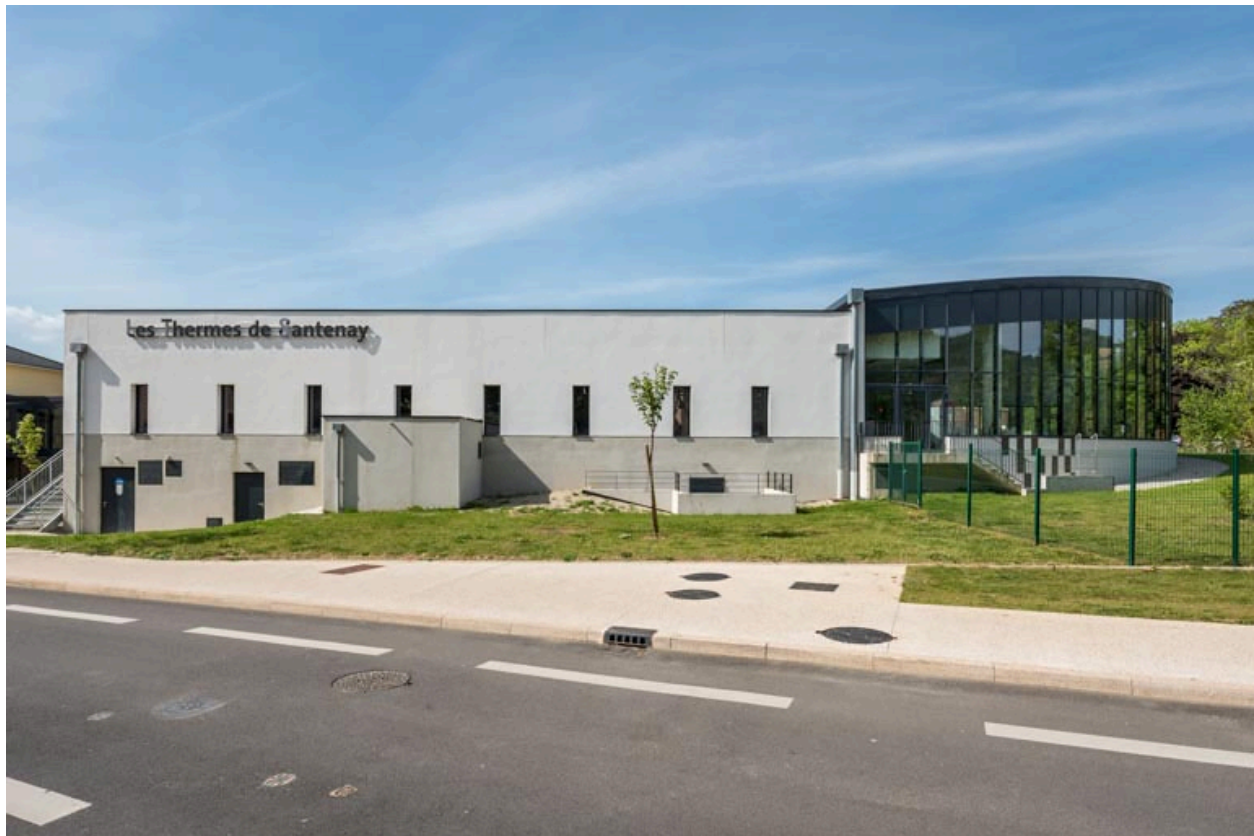
Vue depuis le nord-est.
