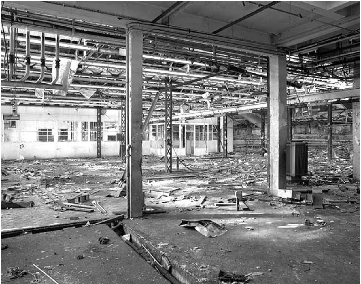
Intérieur du bâtiment (3).
