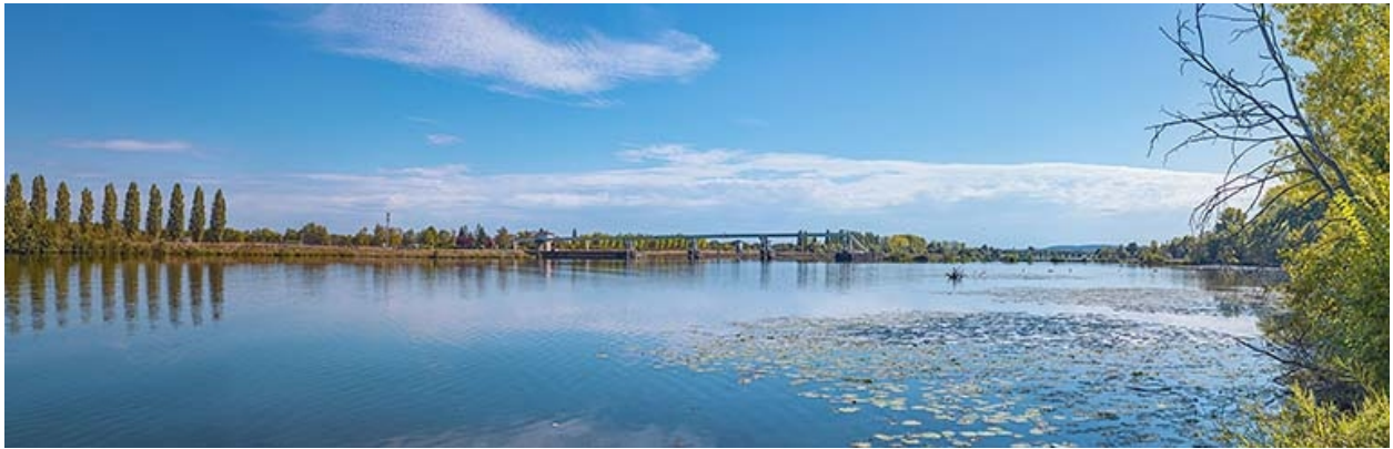
Le barrage, vu d'amont.
