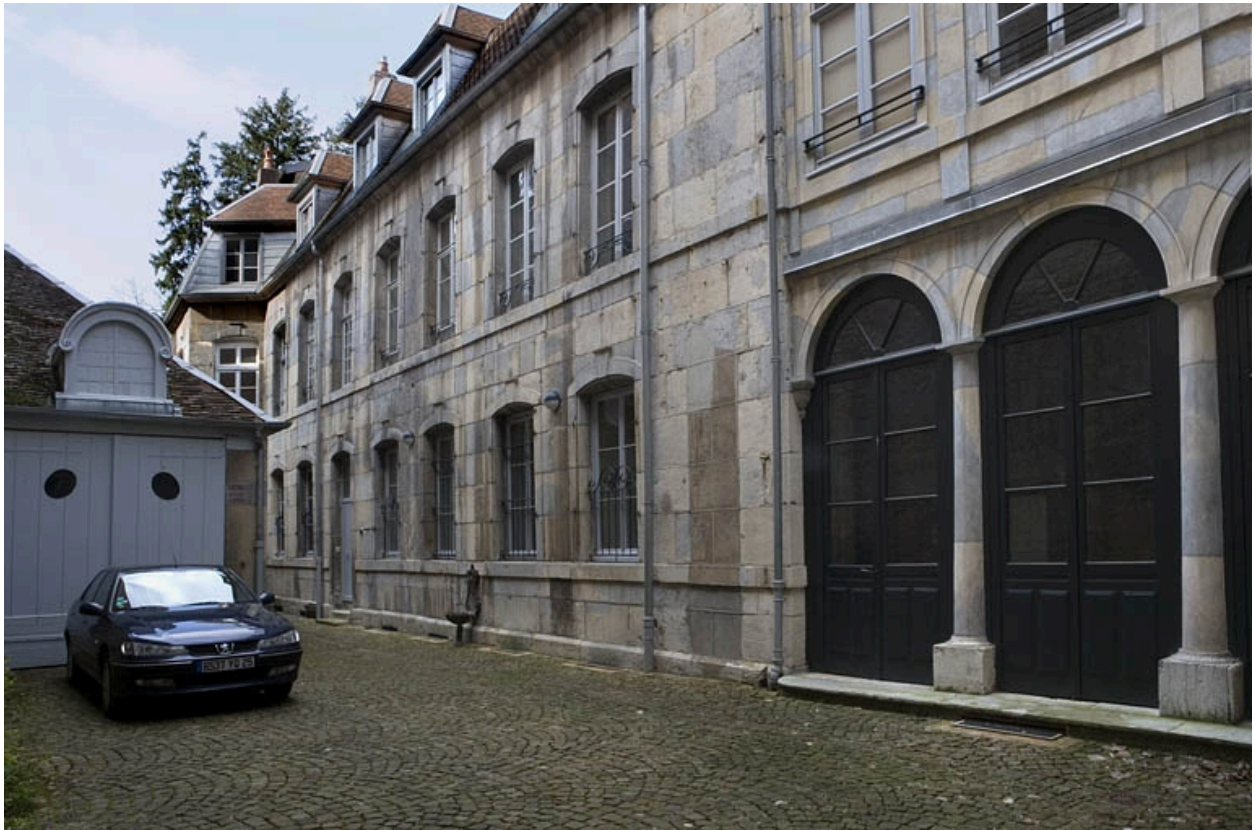
Vue d'ensemble de l' aile sur cour.
