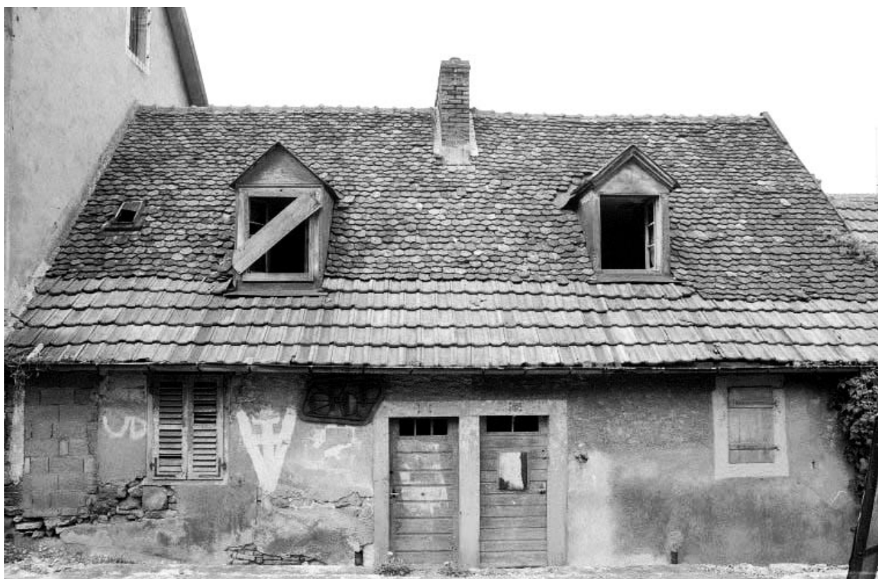
Elevation antérieure, rue de la Poste.
