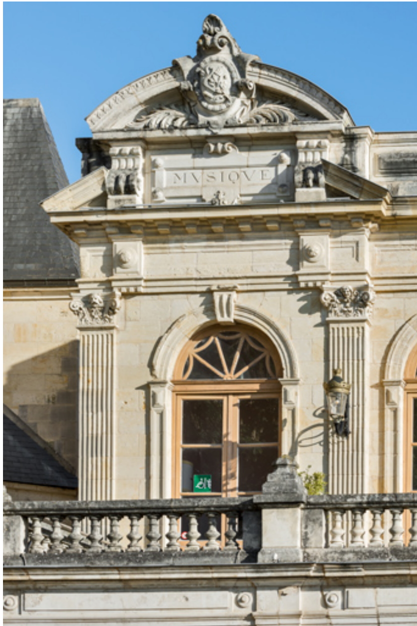
Travée gauche de la façade, à l'étage carré.
