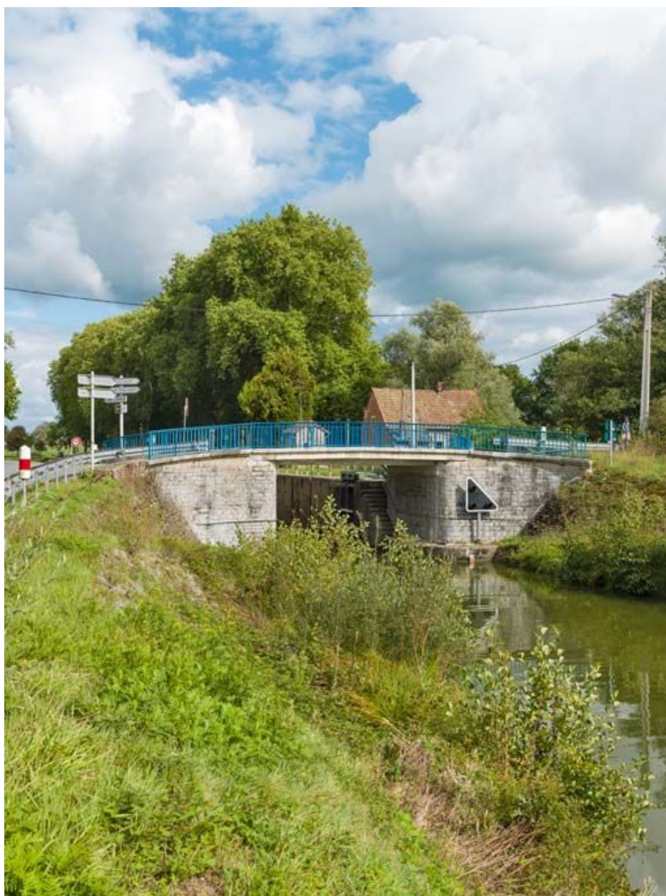
Vue d'ensemble du pont.
