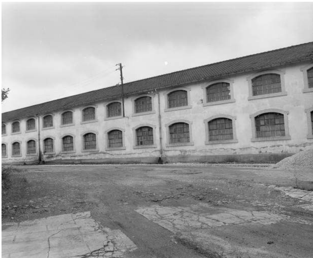
Façade nord de l'atelier des pompes en 1981.
