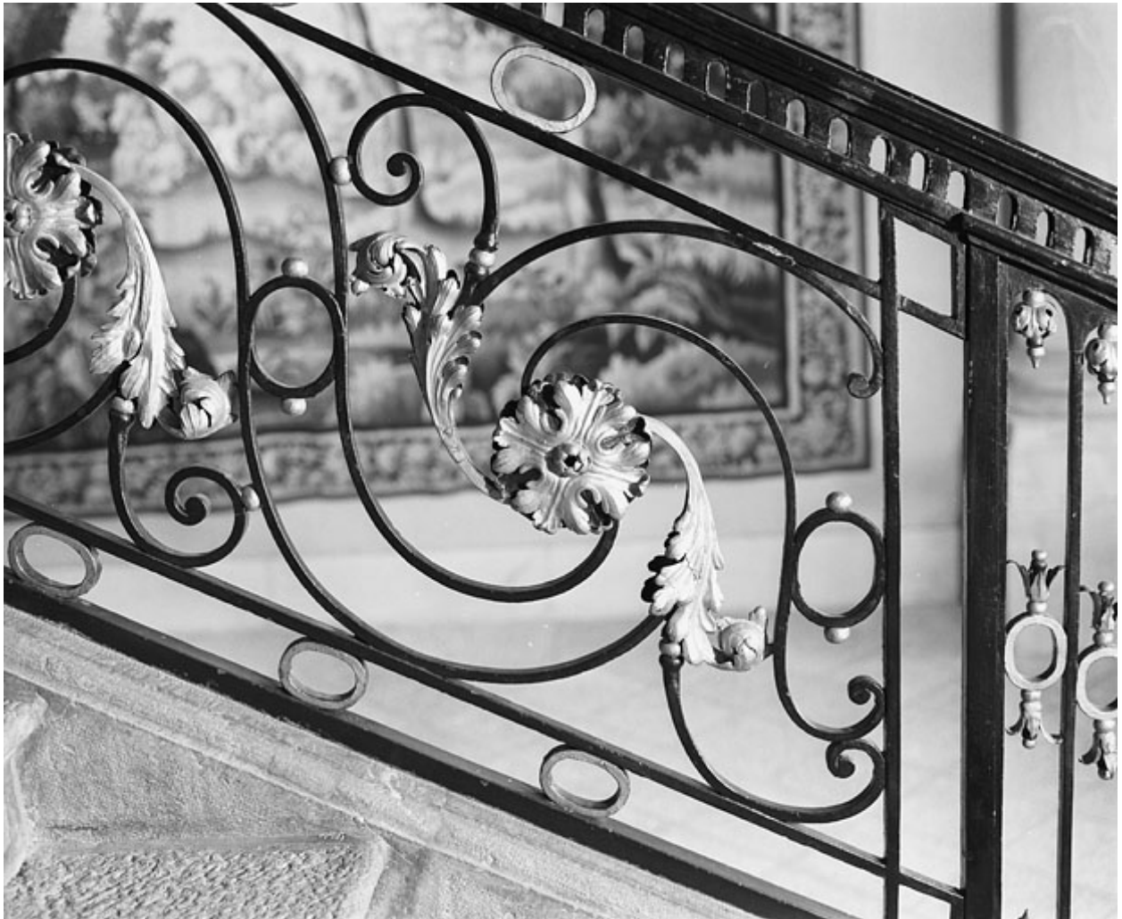
Intérieur, escalier : détail des motifs de la rampe en ferronnerie : vue rapprochée.
