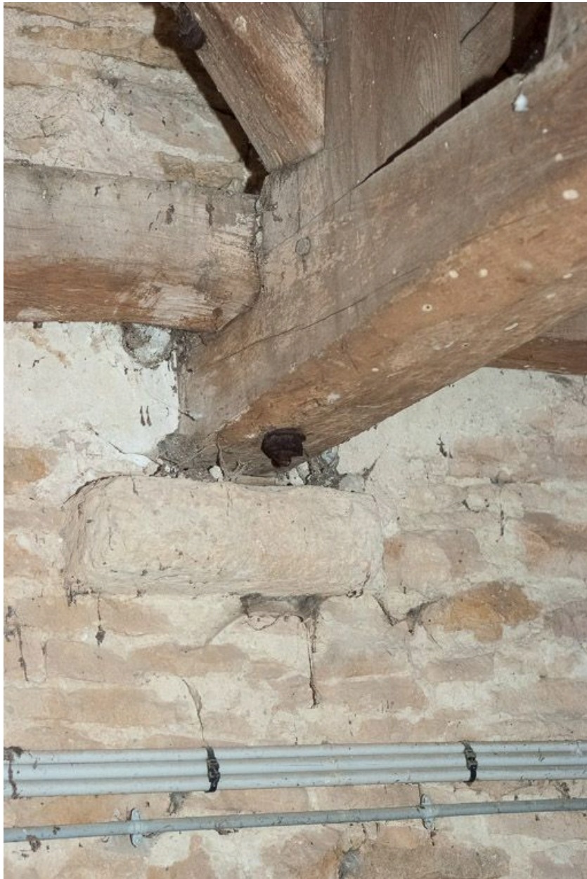
Détail d'un support en pierre du beffroi.
