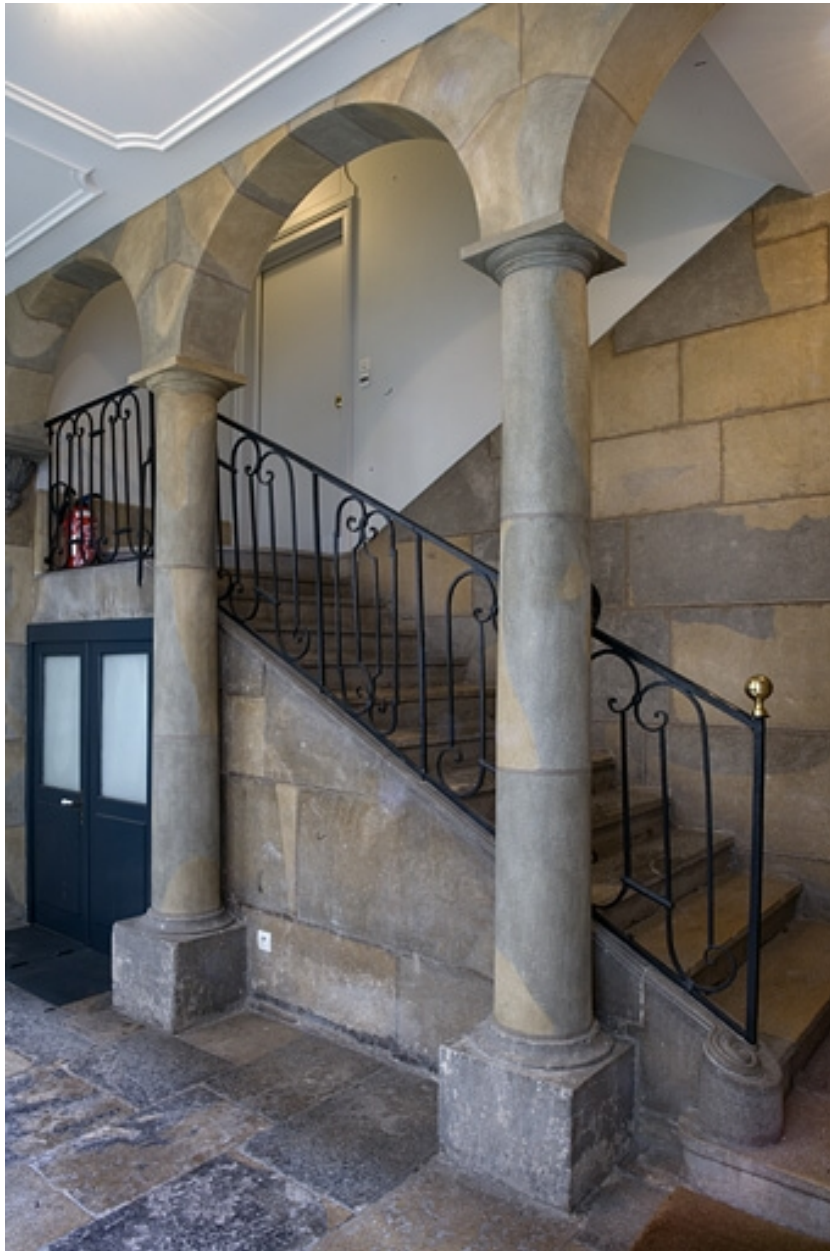
Vue d'ensemble de l'escalier.
