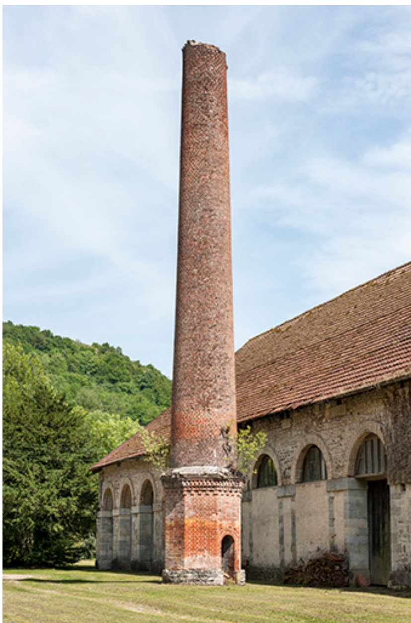
Cheminée de la tuilerie.
