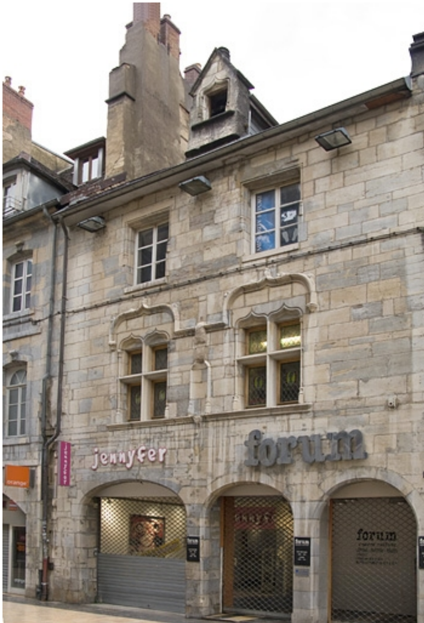
Façade antérieure du 15 Grande Rue : de trois quarts droit.
