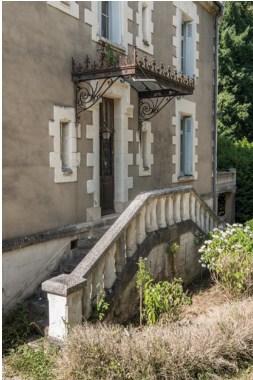
Perron de la façade sud-est.
