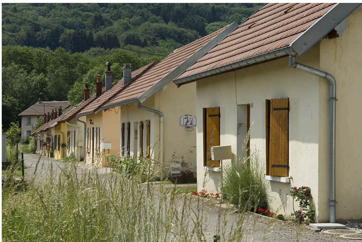
Vue d'ensemble de la cité ouvrière.
