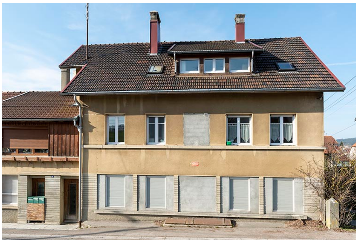
Façade antérieure de l'atelier.
