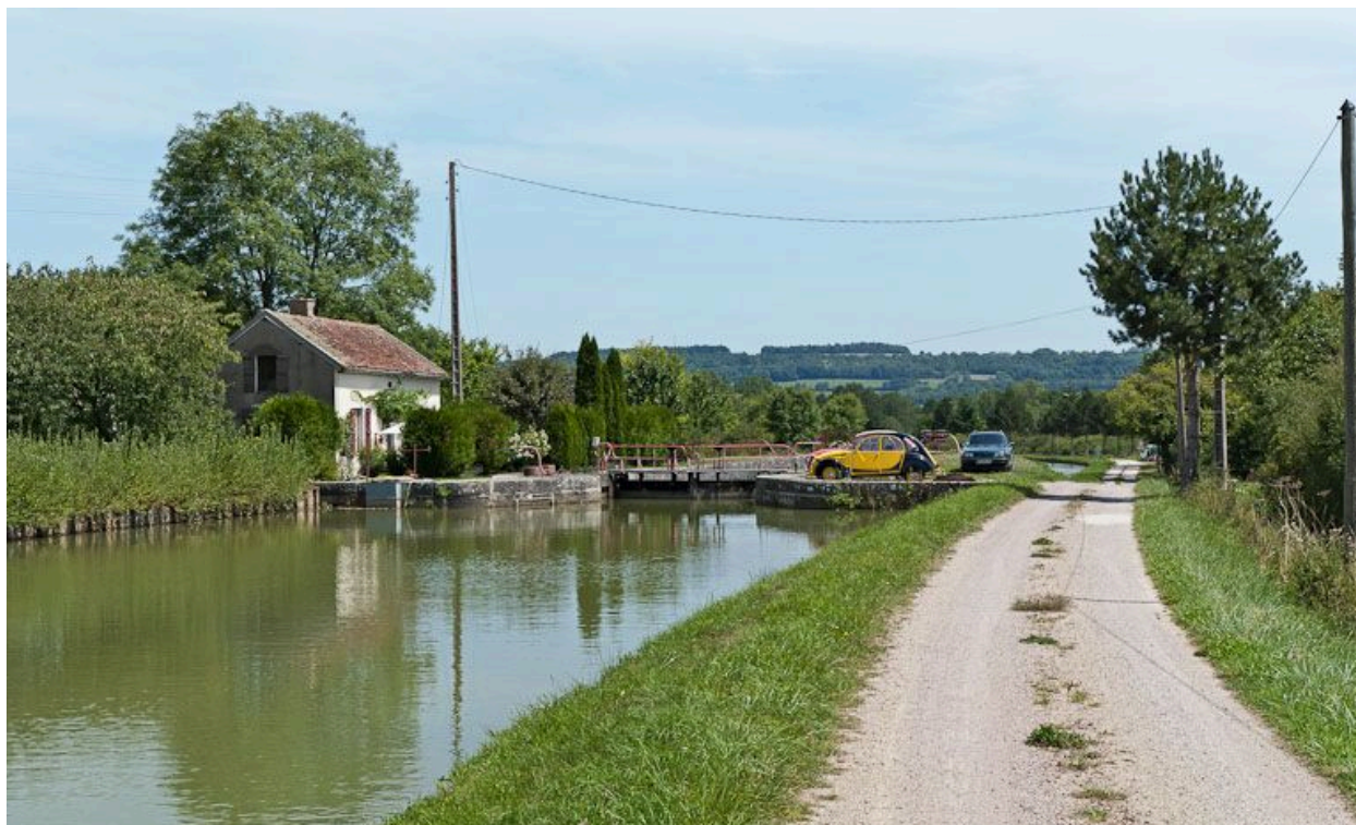
Vue du site d'écluse depuis l'amont.
