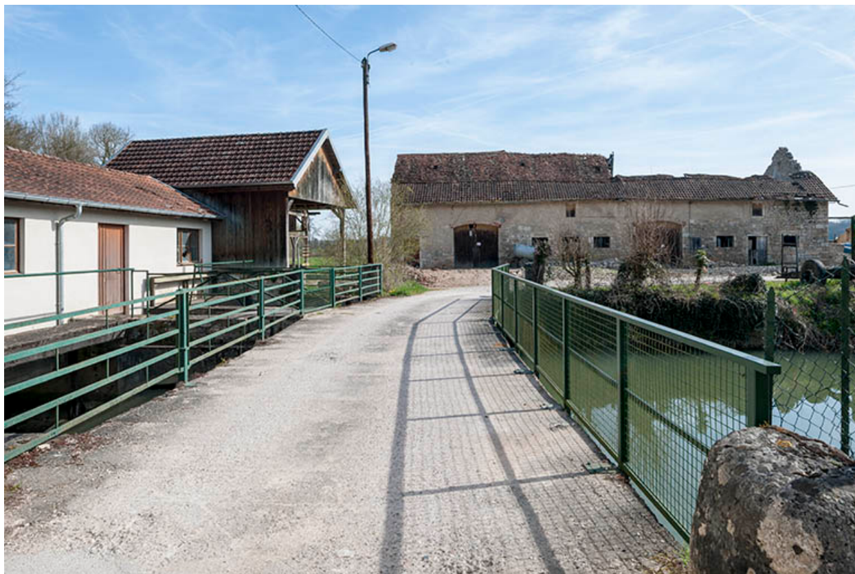
Centrale hydroélectrique (à gauche) et bâtiment agricole.
