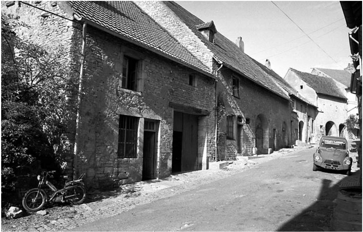
Ferme située rue Bizot.
