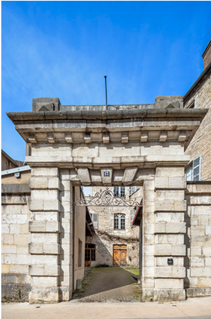
Porte monumentale de la cour.
