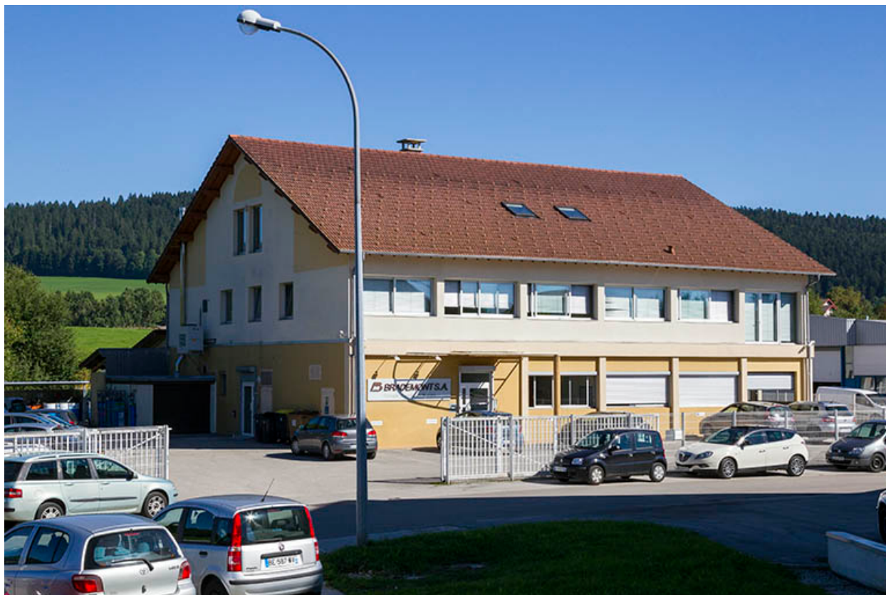
Façades antérieure et latérale gauche.
