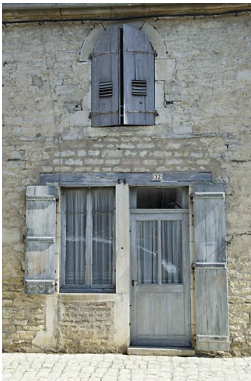
Travée de la façade du logement ouvrier.
