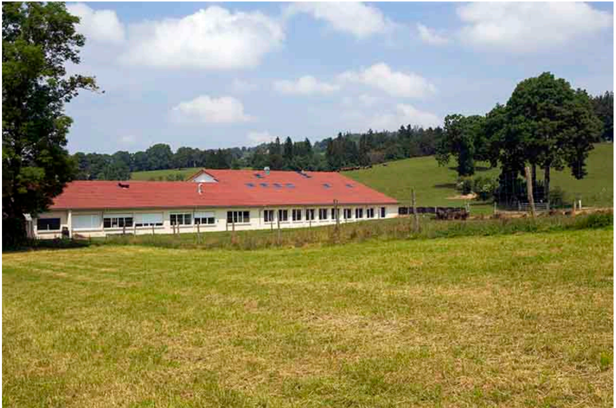
Façade postérieure (sud), de trois quarts gauche.
