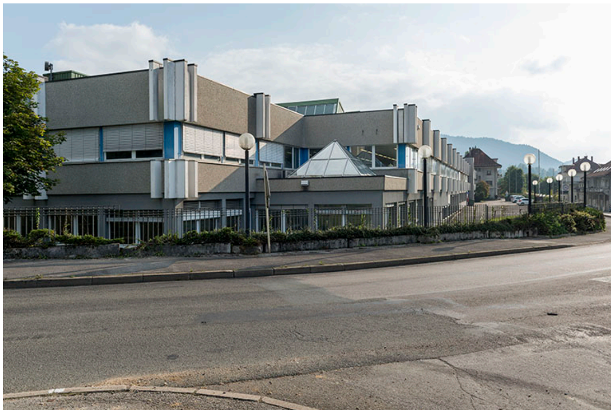
Façades nord et ouest.
