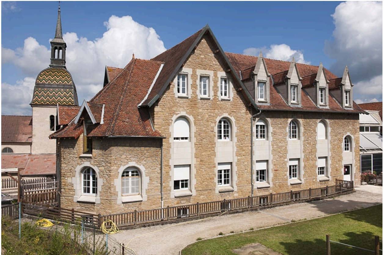
Bâtiment (G), façade postérieure, vue de trois quart gauche.
