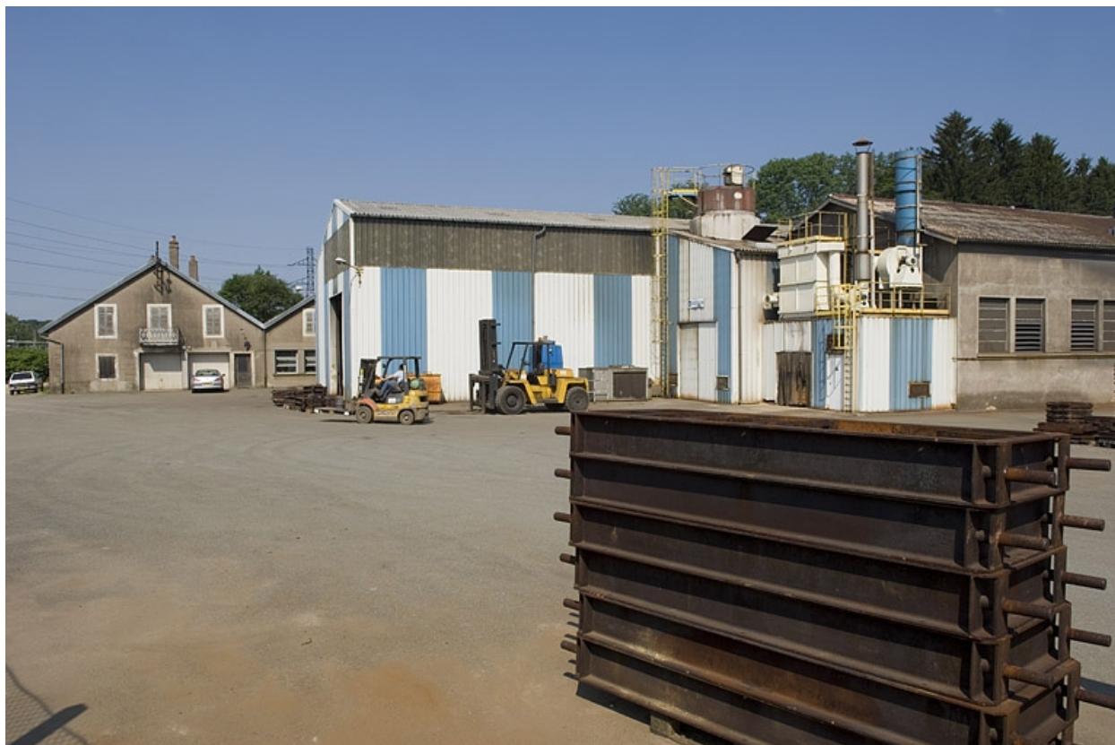
L'ancien et le nouvel atelier de fonderie.
