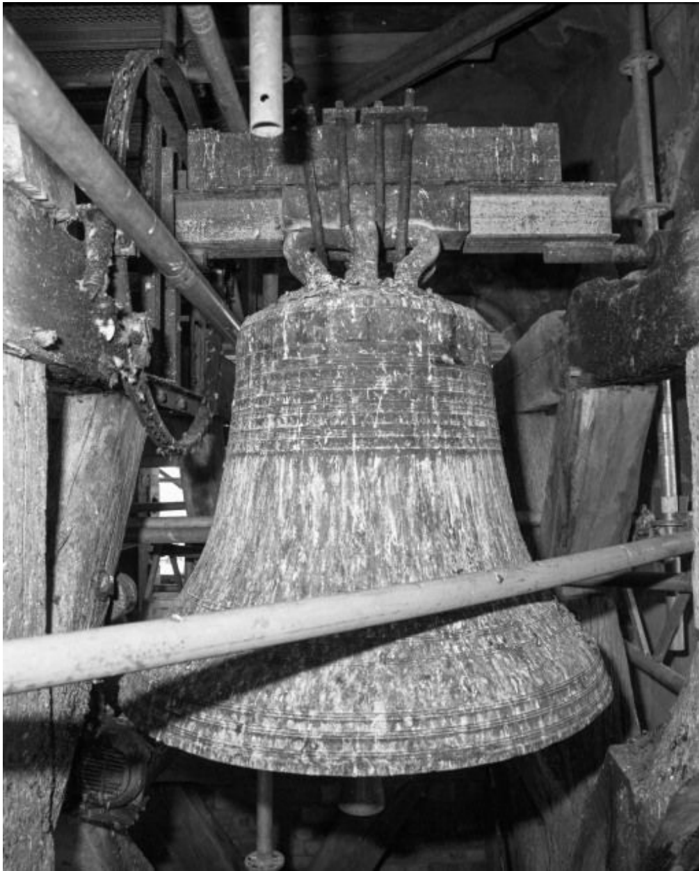
Vue pendant les travaux du clocher.
