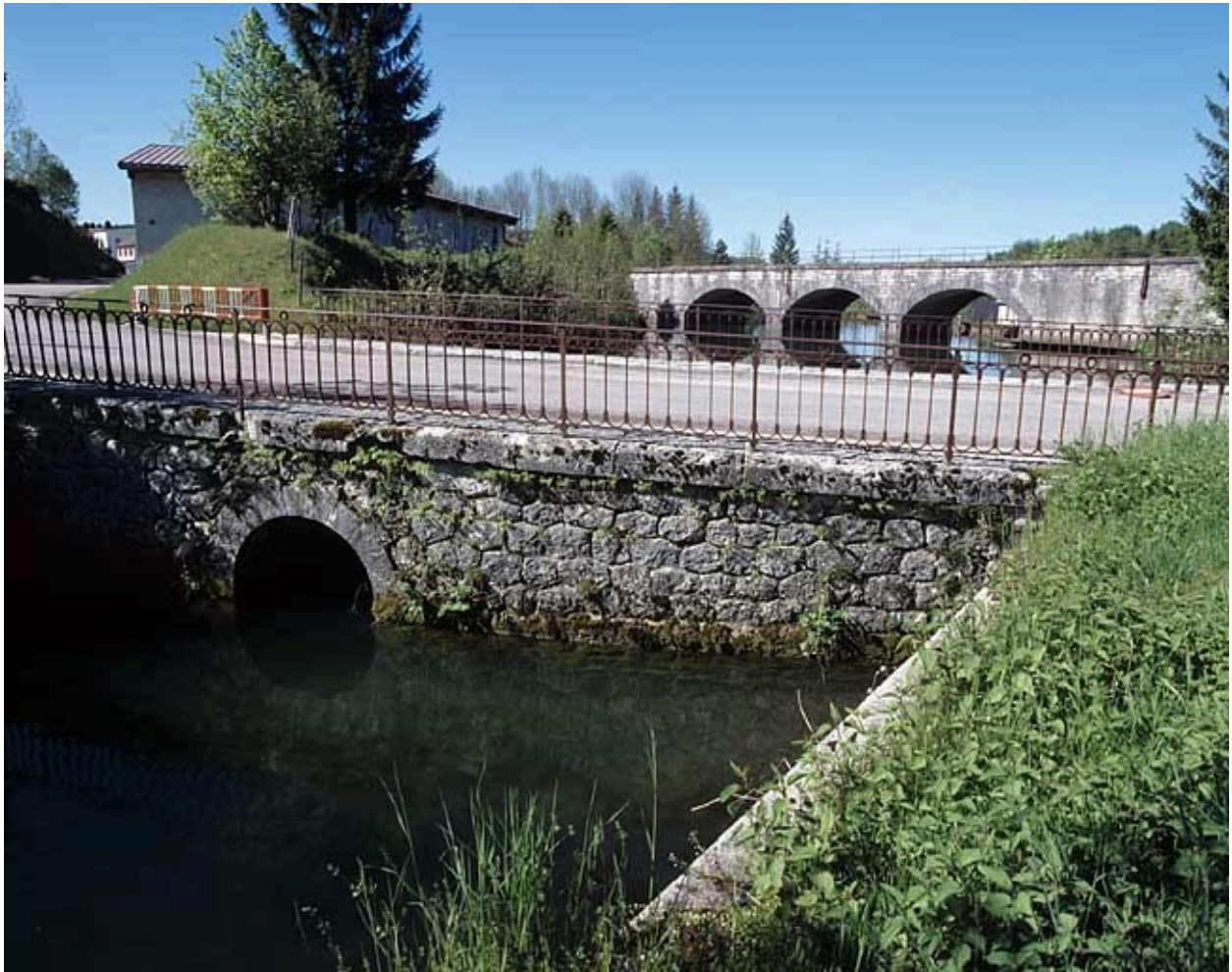
Vue d'ensemble depuis le pont routier (nord-est), en amont sur le ruisseau.
