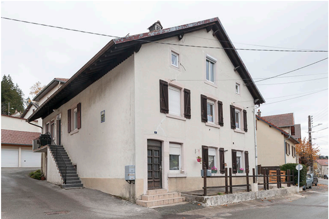
Maison : façades antérieure et latérale gauche.
