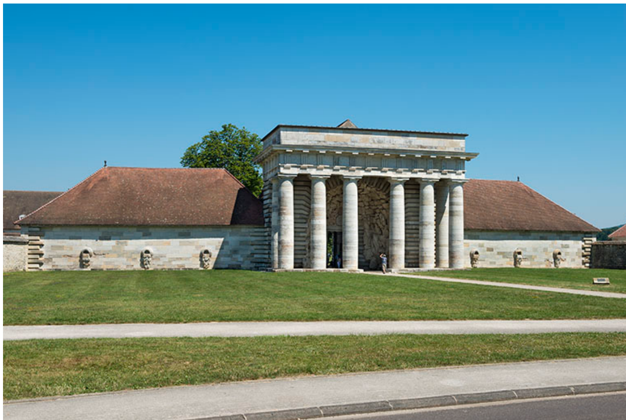
Bâtiment d'entrée, depuis le sud.
