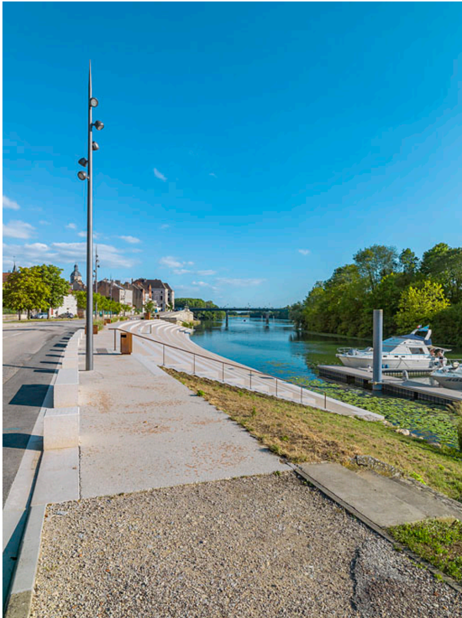
Vue d'ensemble d'amont des quais après leur réaménagement.
