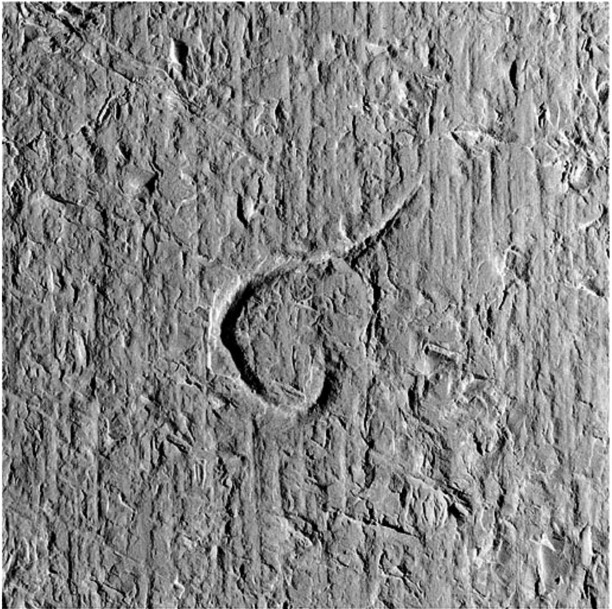
Traces de laie et signe lapidaire dans la septième travée de la coursière du collatéral sud.
