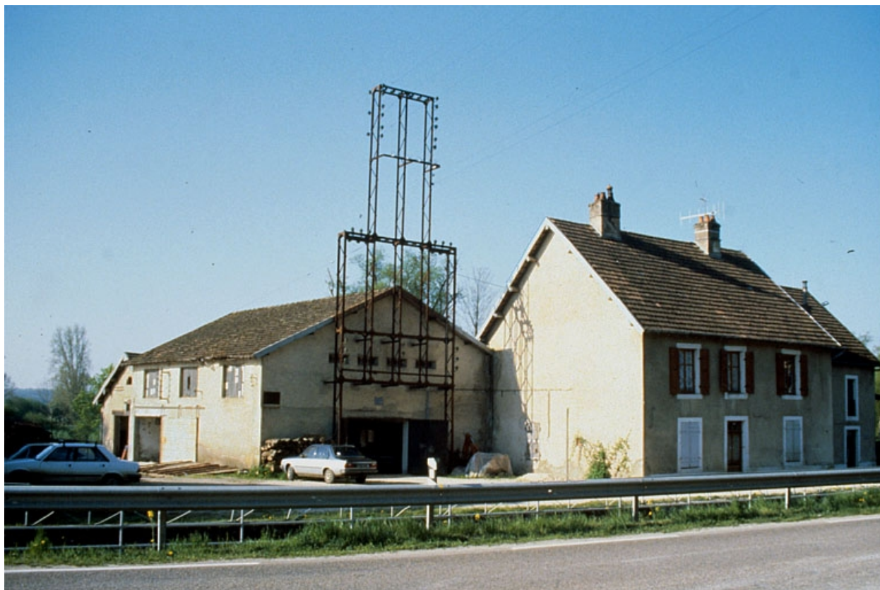
Centrale et maison vues du nord.
