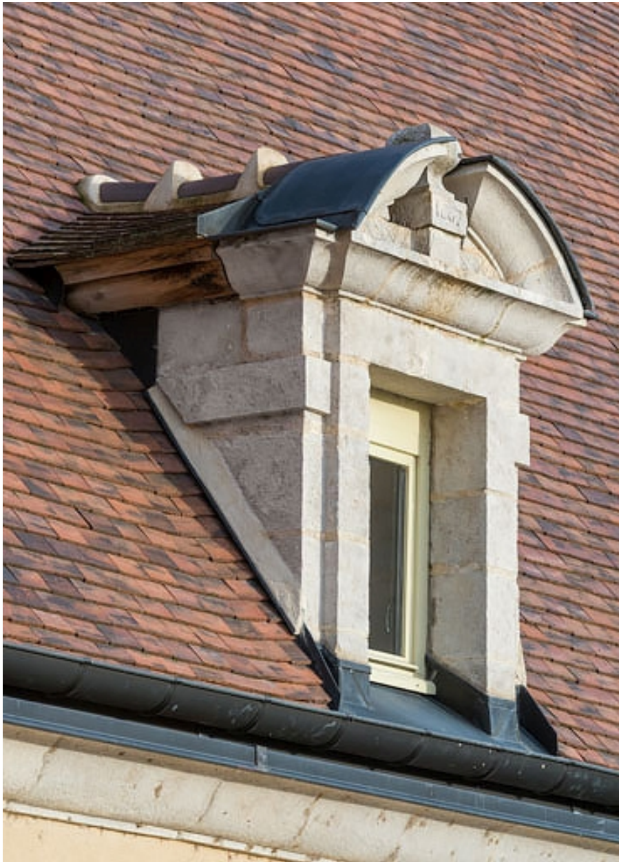
Aile est, façade antérieure : lucarne centrale.
