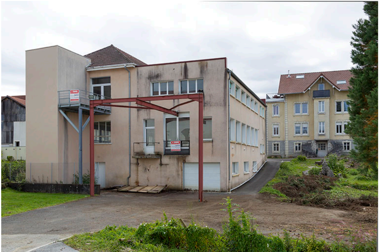
Usine : façade postérieure, de trois quarts droite.
