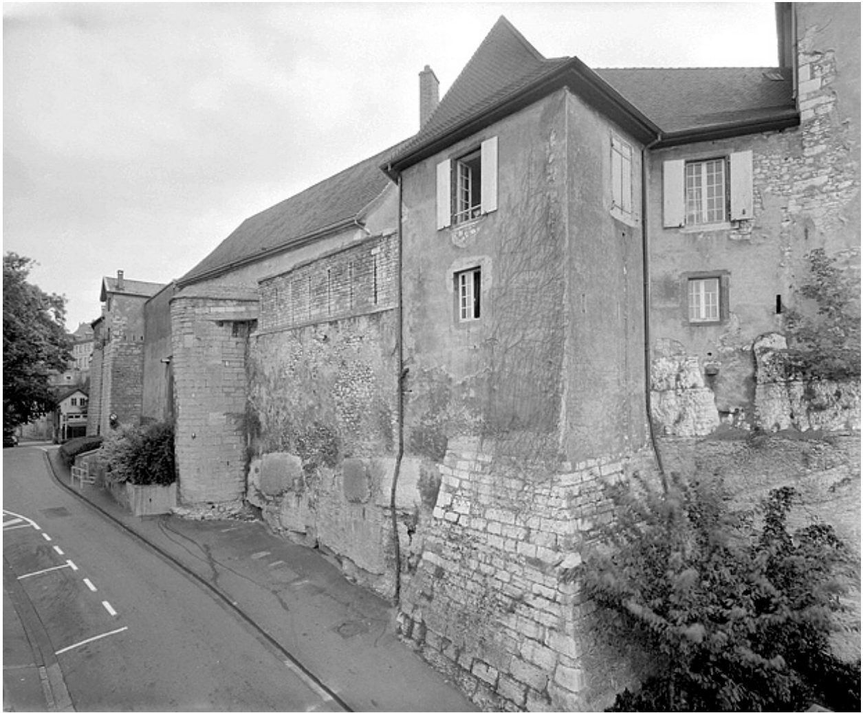
Enceinte. Partie près de la porte (d).
