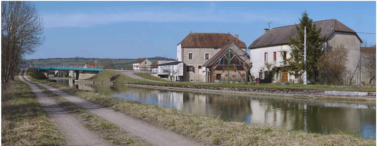
Arrivée en amont du pont à Clamerey : fermes sur la rive droite.
