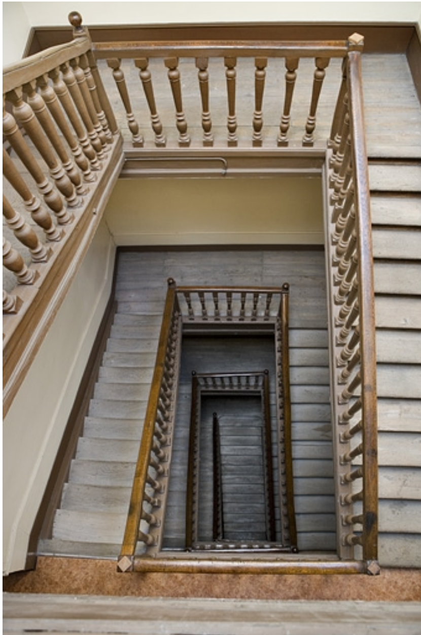
Vue d'ensemble de l'escalier.
