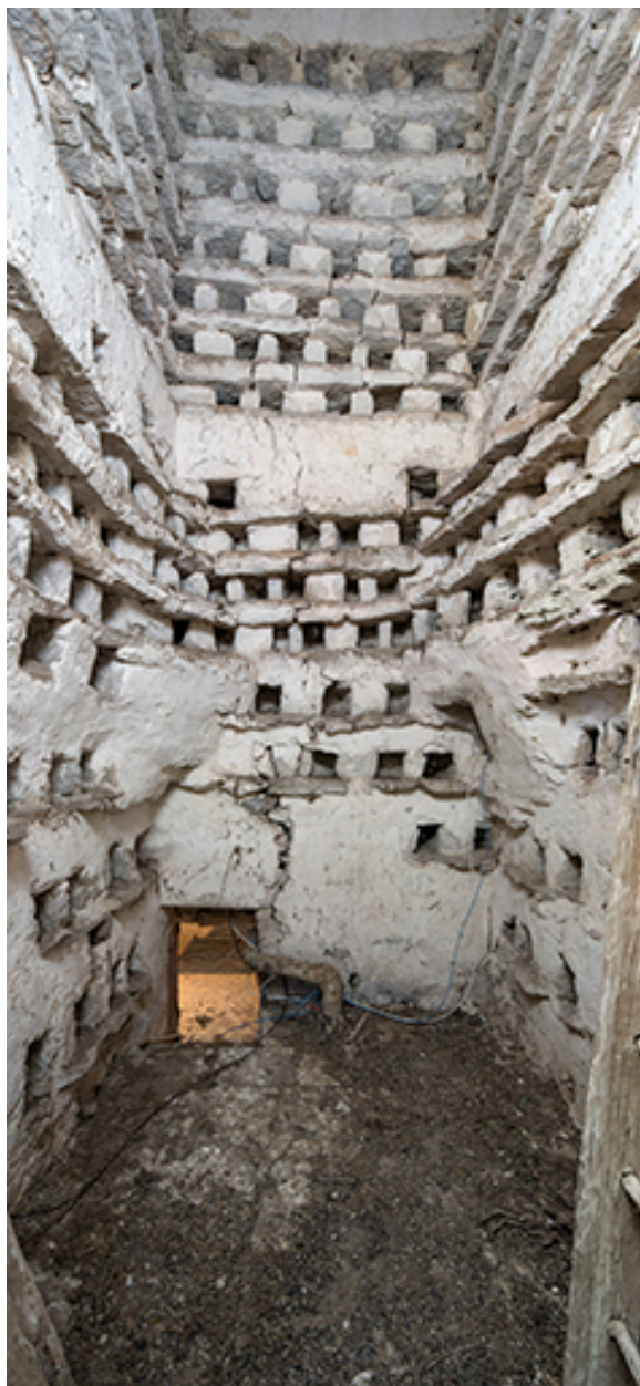
Le quatrième niveau du colombier, de l'intérieur.
